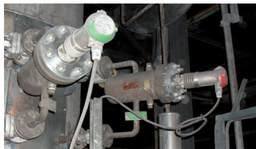
Trimod Besta Interruttore di livello tipo: HAA 22C01 041 Trimod Besta Camera con interruttore tipo: I021-1C0RC1
