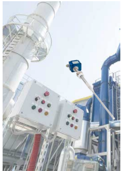
Controllo di livello capacitivo con protezione dalla corrosione
