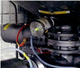
Vista del sensore installato all'esterno
