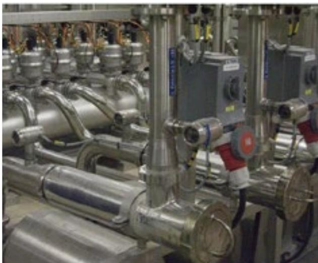
La pressione nelle tubazioni al sistema di pulizia CIP e nelle tubazioni di ritorno delle soluzioni è controllata da trasmettitori di pressione di **KLAY INSTRUMENTS** serie **8000-SAN** o **2000-SAN**.
