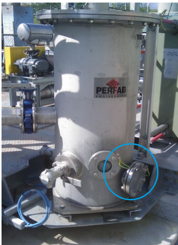
Interruttore di livello Trimod B Besta per allarme di minimo
