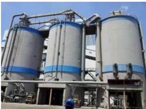
Il cliente in Malesia ha utilizzato la tecnologia TDR nelle principali centrali elettriche per misurare il livello del calcare in polvere.
