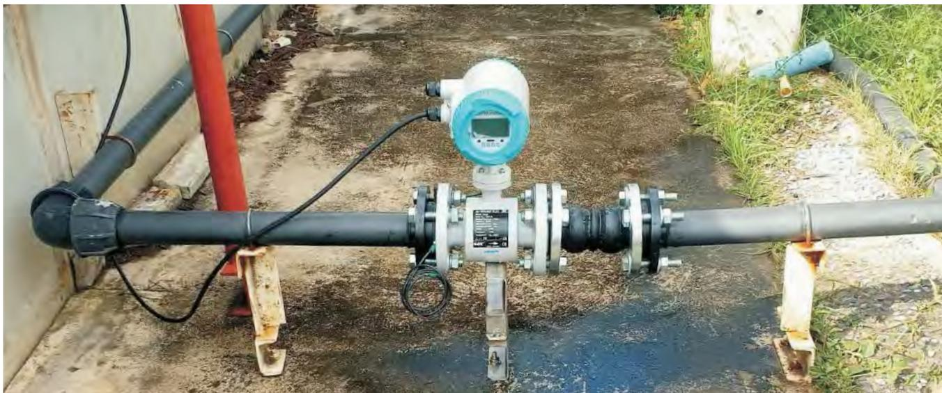
Il misuratore di portata elettromagnetico con attacco flangiato **S-MAG** è utilizzato in molti settori industriali soprattutto perché non è soggetto a ostruzioni e fornisce misure economiche e accurate.
